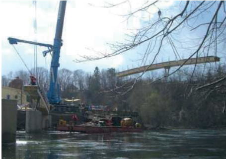
Montage eines Teilstücks einer Hohlkastenbrücke, das vorher im Werk weitestgehend vorgefertigt und per Schwerlastkraftwagen zum Zielort gebracht wurde.
